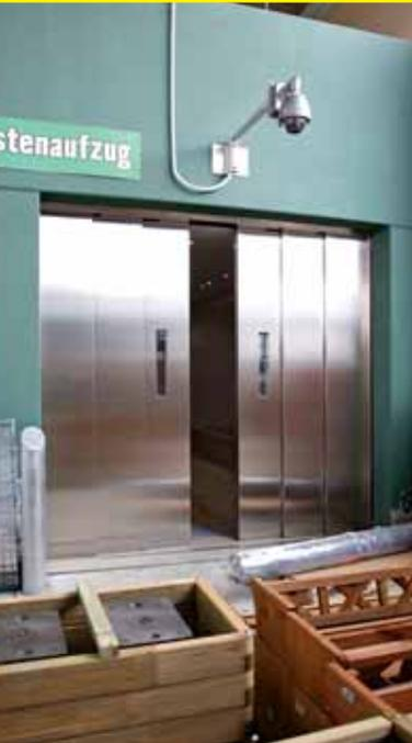
MEILLER Schiebetüren in Industrieausführung der **Baureihen 21, 22, 28, 31 und 32** sind je nach Modell und Ausführung von Türbreite 700 mm bis 3500 mm und Türblatthöhe 2000 mm bis 3500 mm erhältlich.
